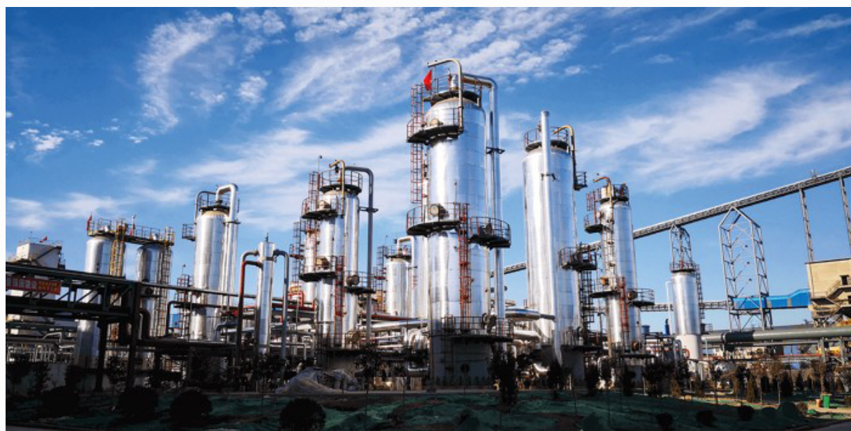
来源：碳循环国际公司（Carbon Recycling International） 碳循环国际公司位于中国河南省安阳市的顺丽工厂，将炼钢过程中产生的二氧化碳转化为甲醇
